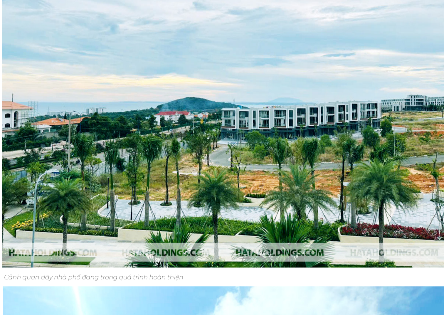
Cảnh quan dãy nhà phố đang trong quá trình hoàn thiện
